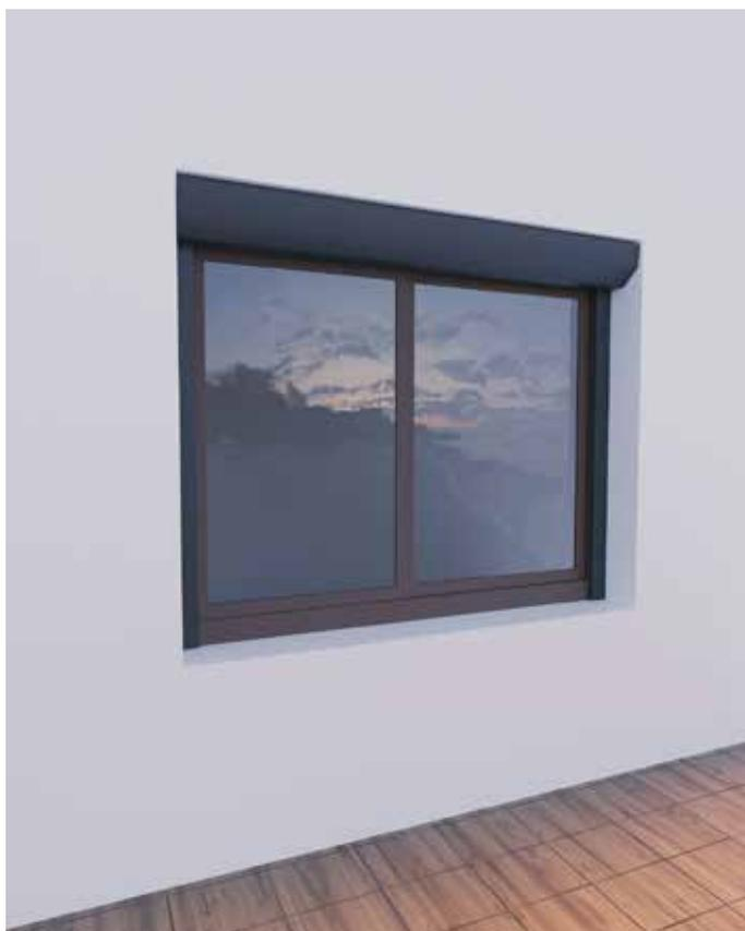
**Pose sous linteau inversé :** le volet roulant est posé sous le linteau, aligné à la façade et son coffre demeure à l'intérieur.
